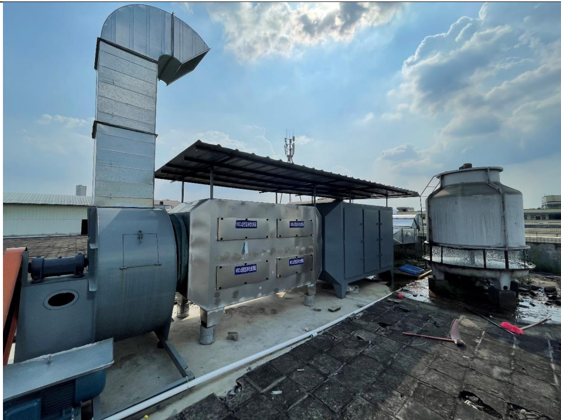
C 栋焊接烟尘、点胶废气处理措施
