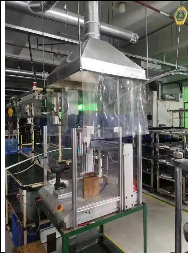
点胶机收集措施
